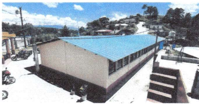
Foto1: mantenimiento estructura metal pintura de techo completo.
