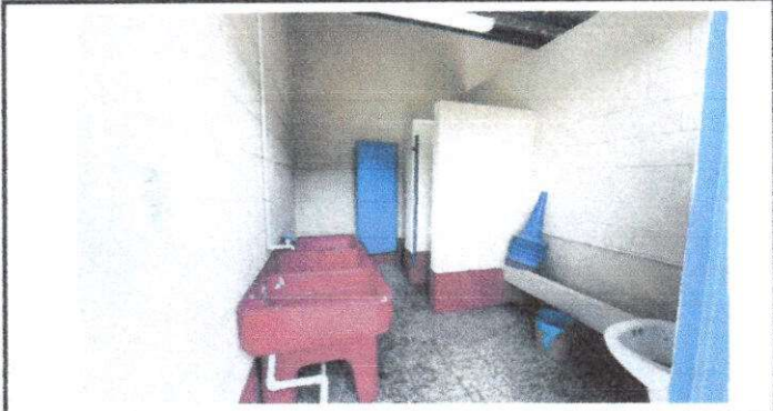
Foto 1: Instalacion de tubería para agua potable incluyendo pila y accesorios
