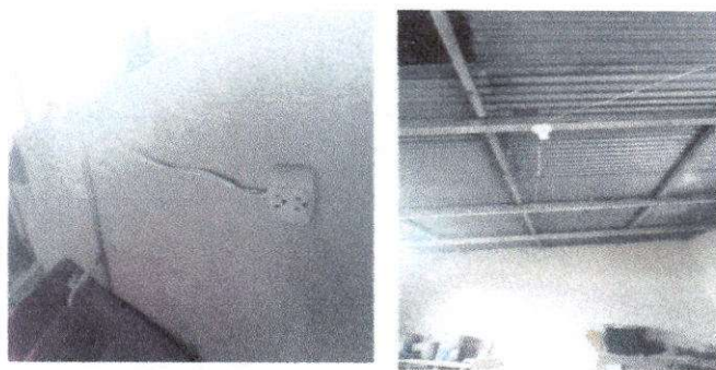
Foto 5: reparacion de sistema electrico.
