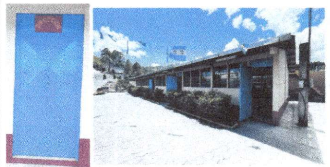
Foto 2: mantenimiento a estructura metal lijado y pintura de puertas
