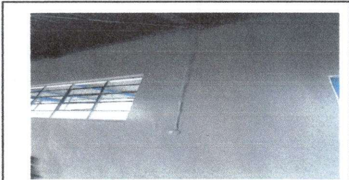
Foto 3: Reparación repello y sernido de pared.
