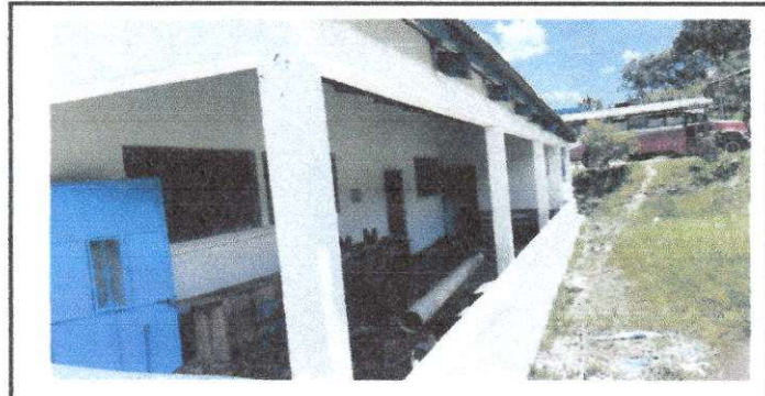
Foto 4: Reparación de bordillo repello y sernido.
