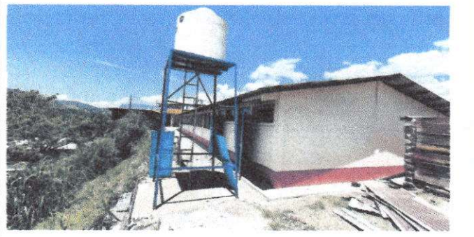
Foto 6: sustitucion de deposito de agua 1700 litros, Basa de concreto y metal
