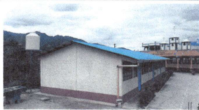
Foto 3: Reparacion bajada de agua pluvial tubo pvc y codos
